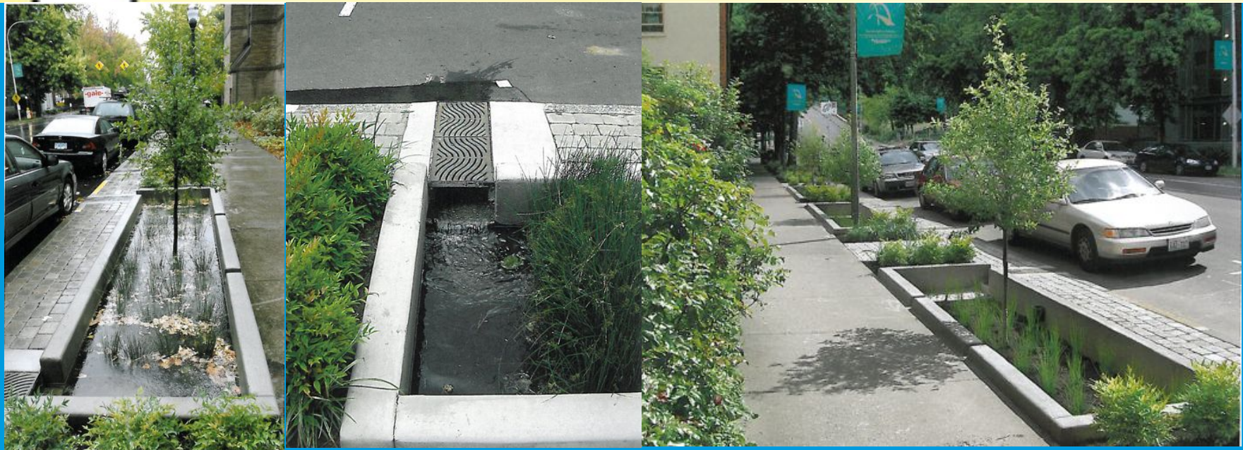
Bacs d'infiltration des eaux pluviales en bordure de rue – Portland, Oregon (Portland Bureau of Environmental Services)
